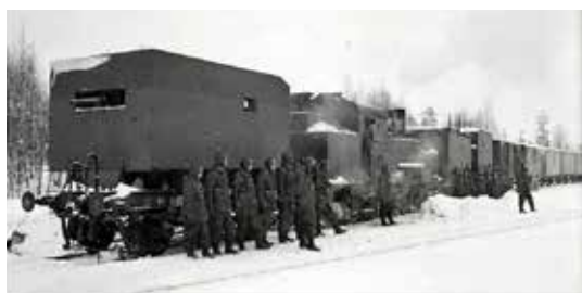
Pansartåget "Boden" med besättning. Ordning: Kanonvagn - lokomotiv - kulsprutevagn - kanonvagn.
