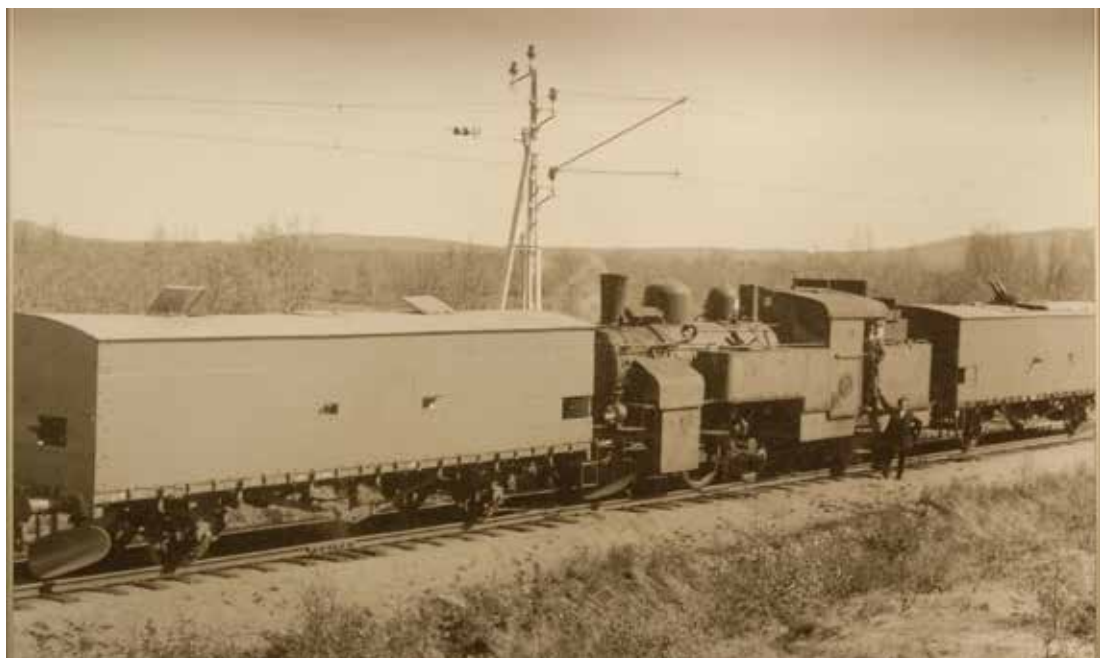
Ännu en bild på "Kiruna". Ordning: kanonvagn – lokomotiv – kulsprutevagn. Här syns pansarskyddet på lokomotivet bra. Överraskande är att skorstenen inte är pansarskyddad, eftersom en sönderskjuten skorsten kraftigt minskar draget i pannan och därmed lokomotivets dragkraft.
