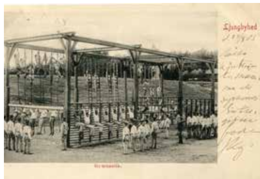
Här övades soldaterna i gymnastik. När regementsmötet var över monterades anläggningen ned.
