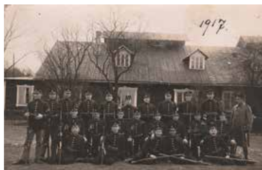
Förlägningsbarack från början av 1880-talet, den låga tillbyggnaden till vänster är sanitetsutrymme och tillkom i början av 1900-talet
