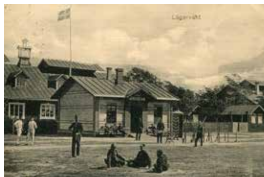
Vaktlokalen, väster om klockbaracken. De små byggnaderna till höger var persedelbodarna, ett per kompani. Tidigare var vaktens slutna del i tält.
